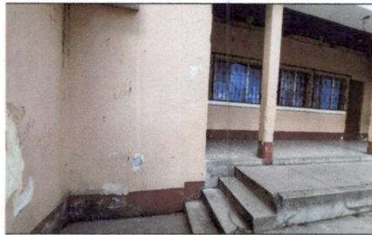
Foto 3: Pintura en muros exteriores e interiores
