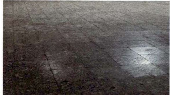
Foto 2: Sustitución de piso de granito
