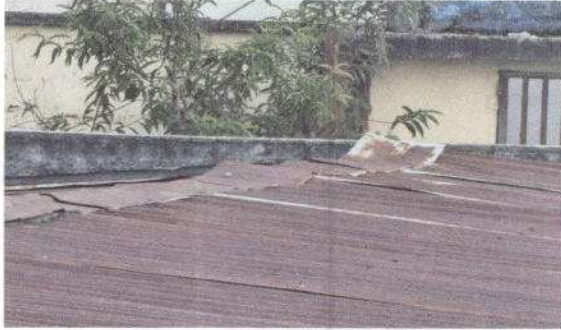
Foto1: Sustitución de lámina, por lámina troquelada aluzinc calibre 26
